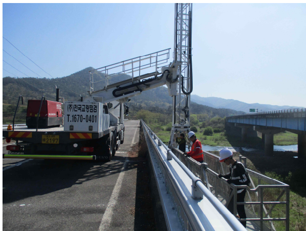
점검차량을 이용한 외관조사
